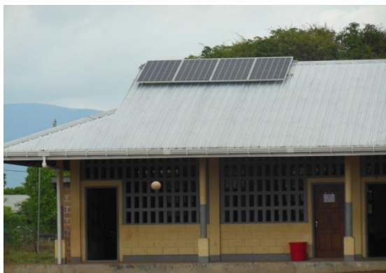
セント・イグナティウス中学校 草の根事業により設置されたソーラーパネル
