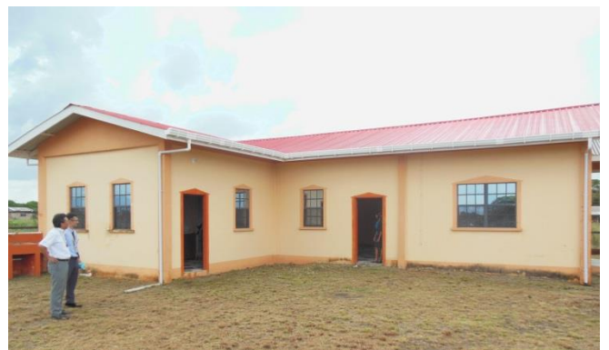
草の根事業により建設されたレサム・スペシャルニーズ・グループ多目的センター
