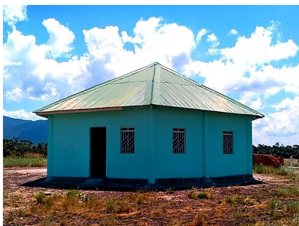
建設された多目的ホール
