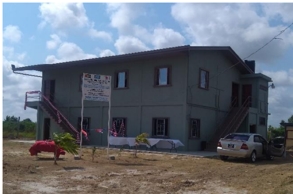
新たに建設された訓練施設の外観
