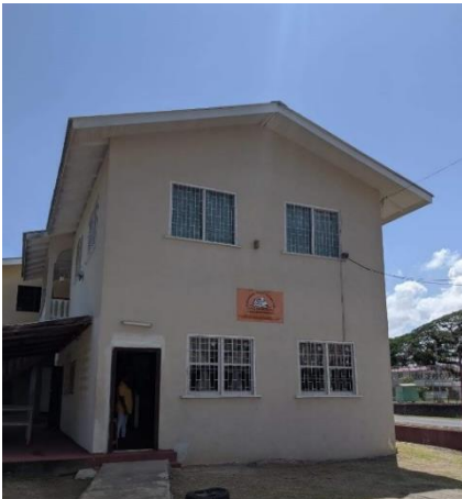
本案件で改修予定のボランティア青少年協会施設 外観
