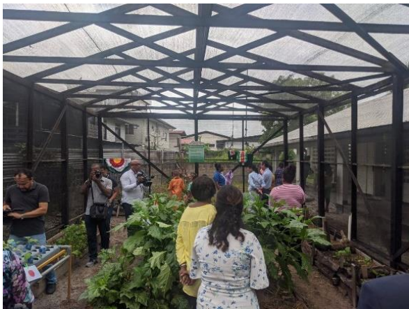
本案件で建設した有機栽培施設
