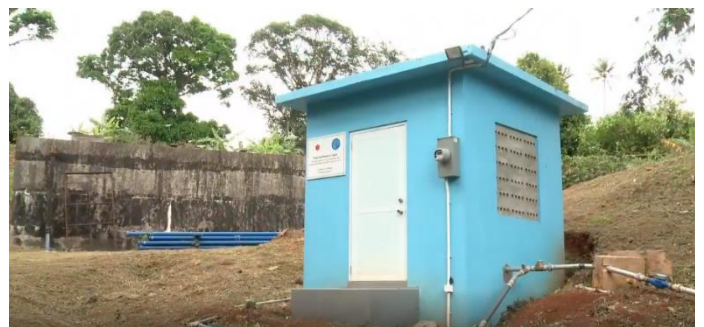
草の根支援で建設されたポンプ収納施設
