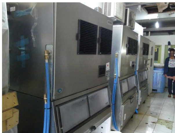
メルビルストリート魚市場に設置された製氷機
